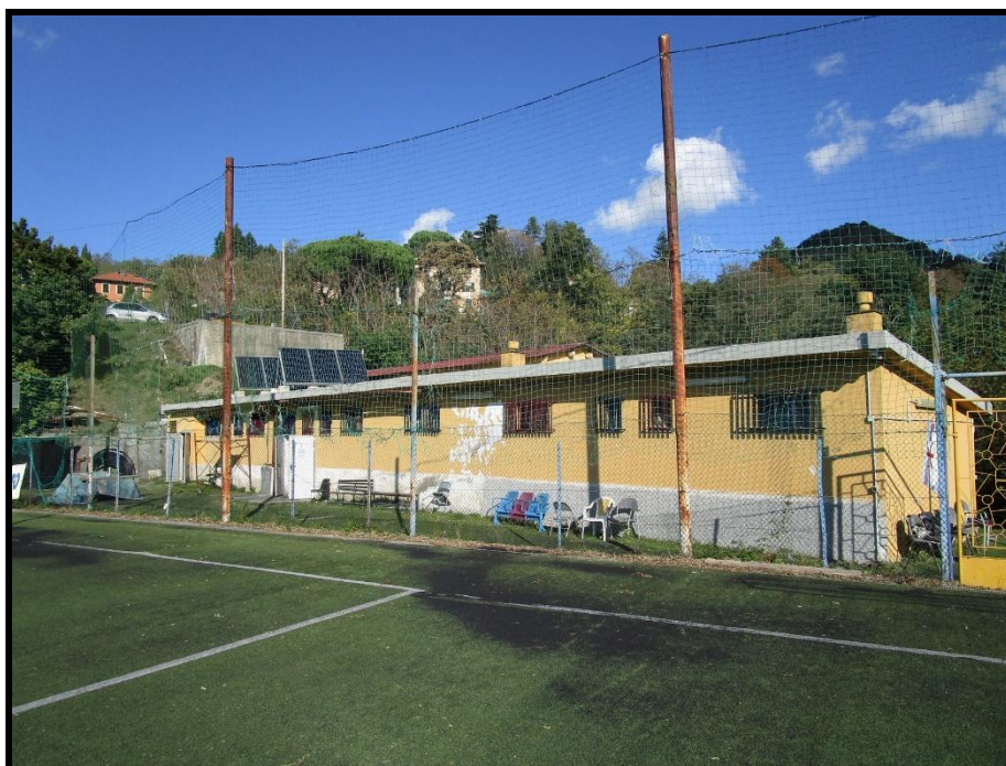
Spogliatoio e locali accessori
